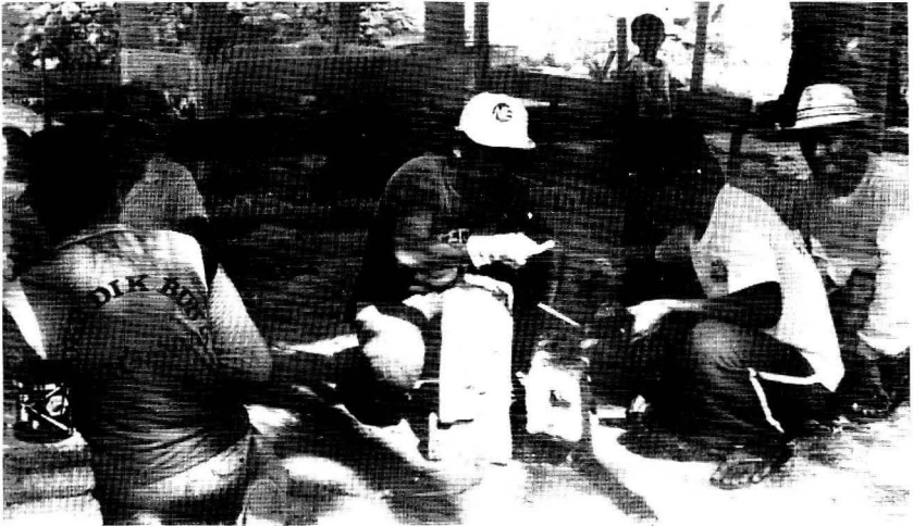
Foto 4. Penyambungan batu-batu yang pecah, Pelinggih Ratu Agung di Pura Dalem Cemara, Serangan.
