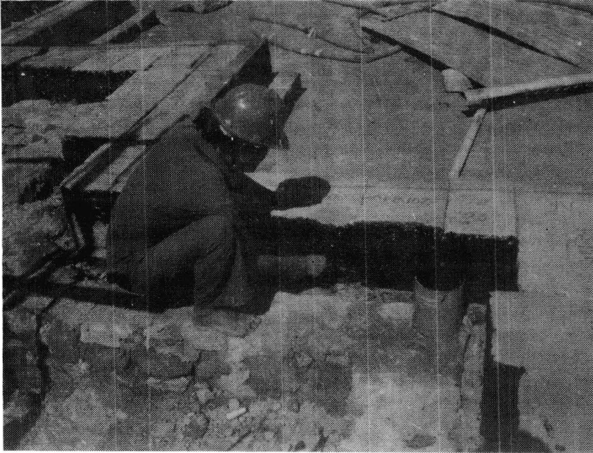
Pembuatan lapisan kedap air dengan cara pengolesan araldite tar pada permukaan batu bagian belakang.
