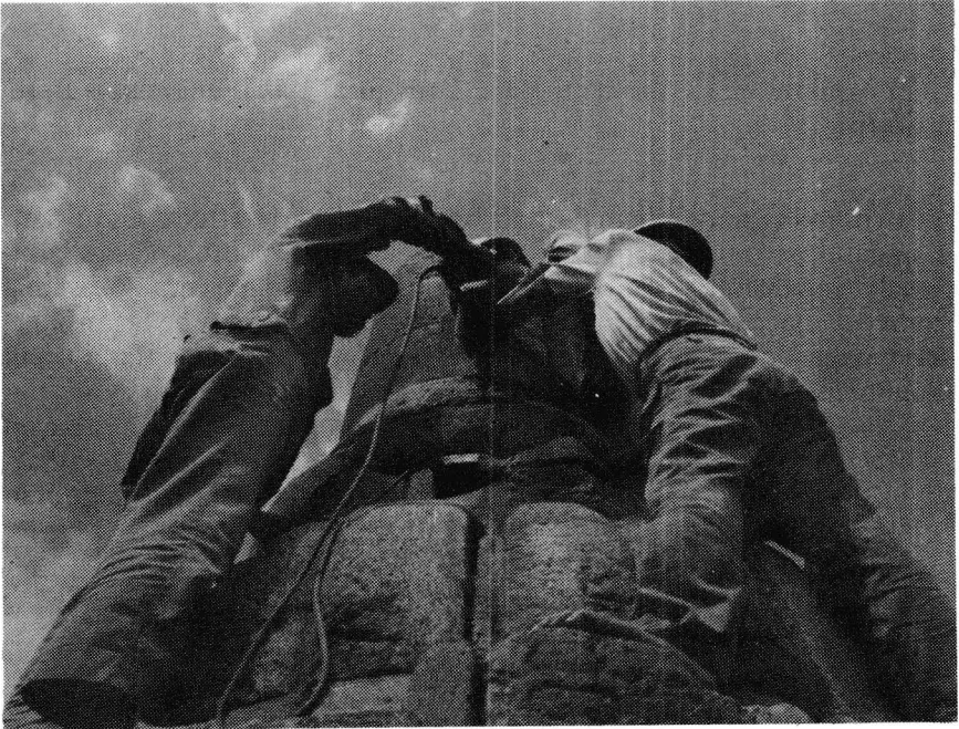
Pemasangan kabel BC di bagian amalaka pusat untuk instalasi penangkal petir.
