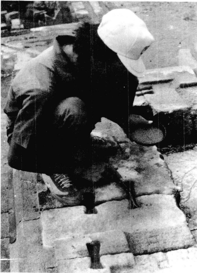
Kegiatan pemasangan ankur untuk pengunci batu luar.
