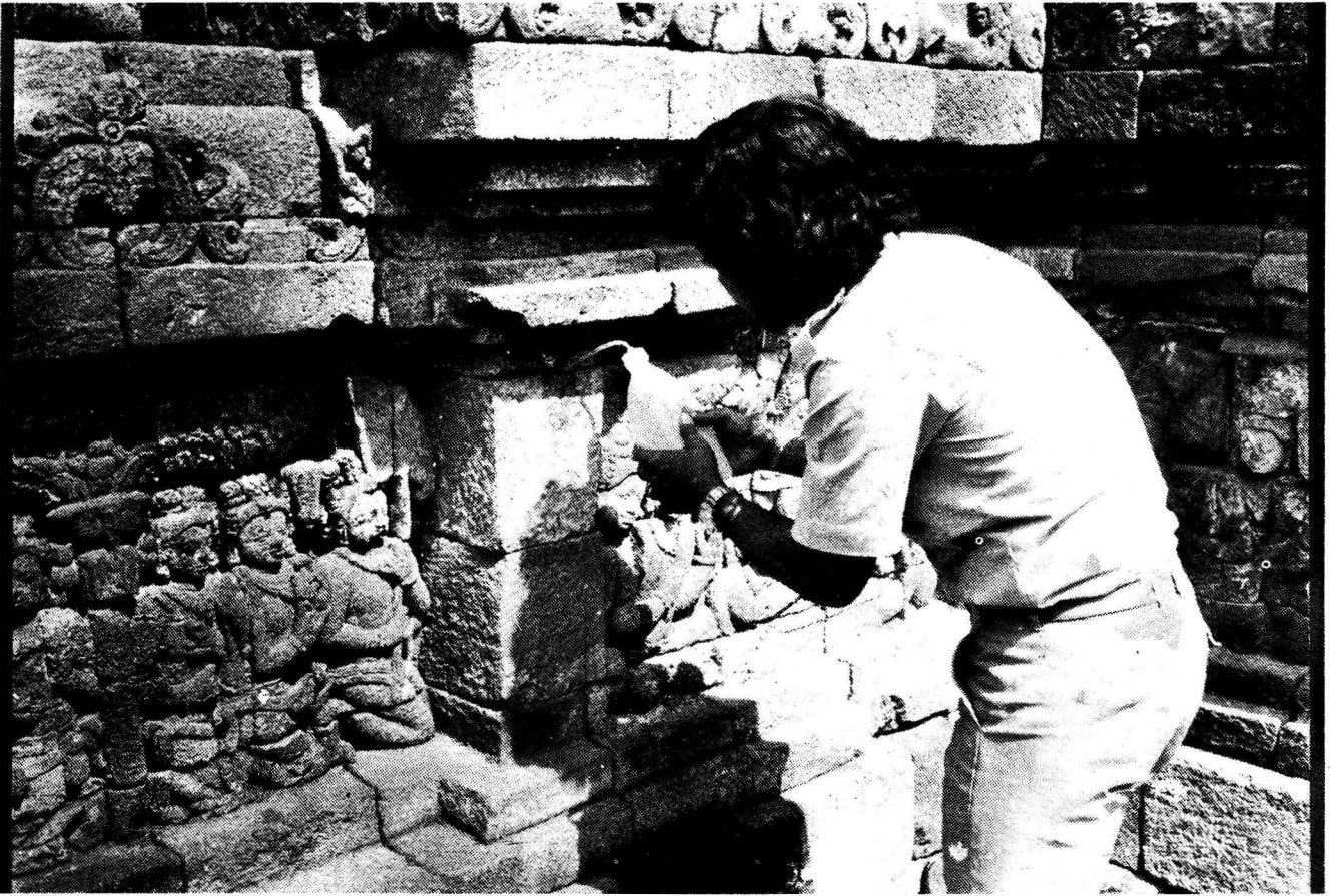
Observasi gejala fisik yang timbul akibat perubahan suhu dan kelembaban permukaan batuan pada Candi Borobudur.
