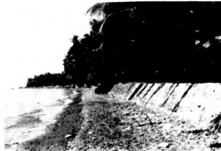
Foto-3: Untuk menghindari proses abrasi lebih jauh yang mengancam situs-situs di wilayah Tejakula dan sekitarnya, maka perlu dilakukan usaha penanggulangan yang lebih terencana dengan melibatkan instansi-instansi. Salah satu bentuk penanggulangan adalah dengan membuat dinding-dinding pantai ( sea wall ).
