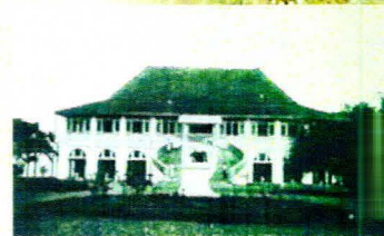
Rumah tinggal residen yang dibangun di bekas reruntuhan Keraton Kuto Lamo
