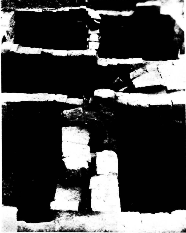
Foto No. 11 Susunan pondasi Candi Induk Banyunibo waktu penggalian
