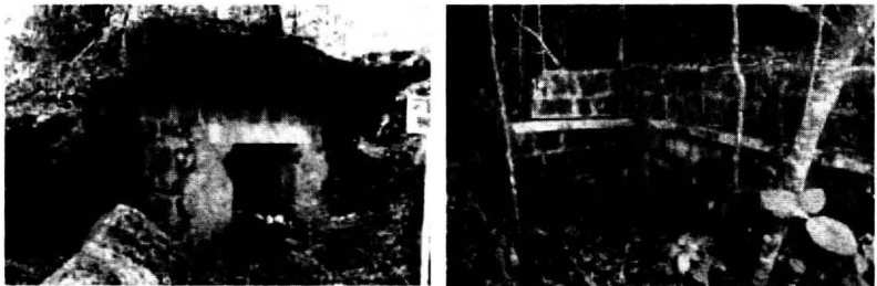
Gambar 6. Benteng di ujung utara Pulau Rubiah (sumber: dokumentasi penulis)
