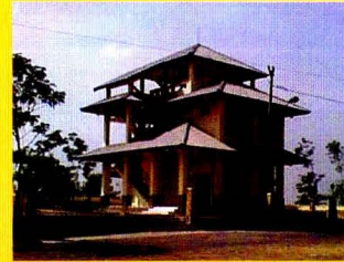
Gbr.64. Pembangunan fasilitas
