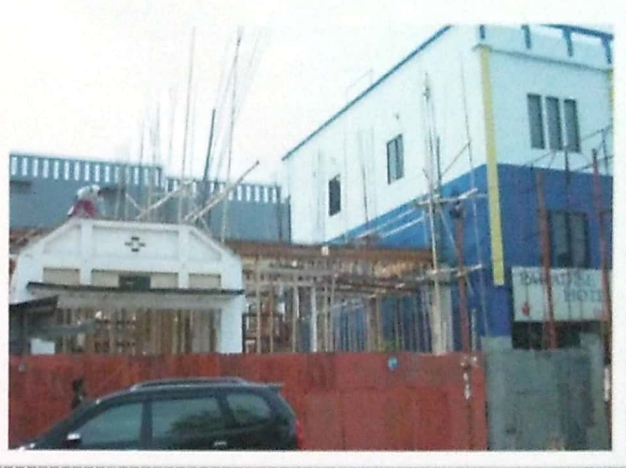
Foto 2. Bangunan Indis yang dibongkar untuk dibangun model baru (dok. Penulis)
