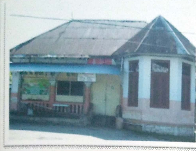
Foto 1. Salah satu potensi bangunan Indis di Kota Gorontalo (dok. Penulis)
