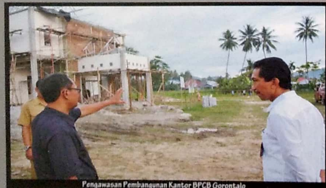
Pengawasan Pembangunan Kantor BPCB Gorontalo
