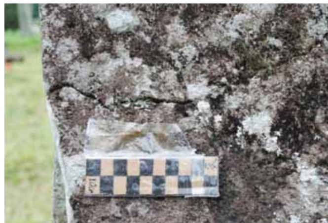
Foto 1. Retakan yang terjadi pada badan waruga
