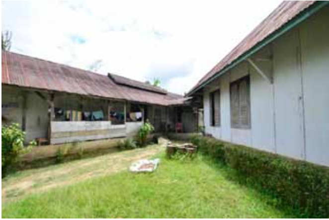
Bangunan Belakang (Dapur)
