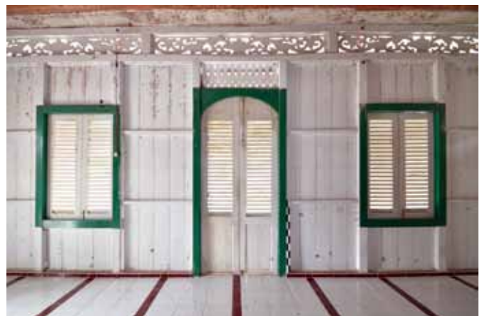
Pintu Utama Atap Masjid
