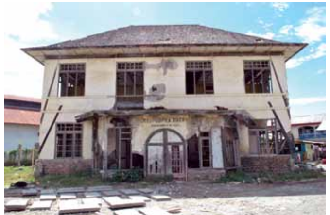
Foto 1. Eks gedung kantor BKKD
