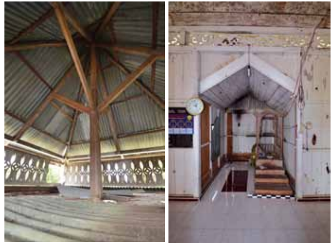
Tiang Utama Atap Masjid (kiri), Mimbar Masjid (kanan).
