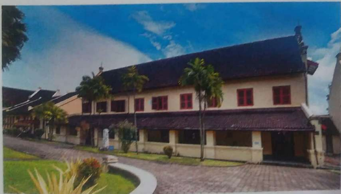
Bangunan J, tahun 1953 dan tahun 2021 (sumber: digitalcollections.universiteitleiden.nl , dan BPCB Prov.Sul-Sel)
