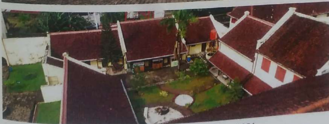
Bangunan D, tahun 1970-an dan tahun 2021 (sumber: BPCB Prov.Sul-Sel)
