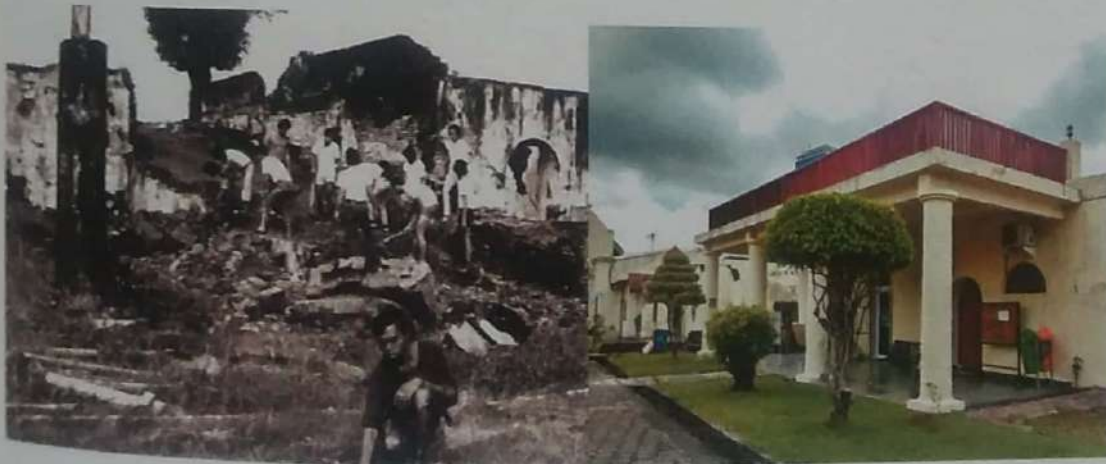
Bangunan B tahun 1970-an dan tahun 2021 (sumber: BPCB Prov. Sul-sel)
