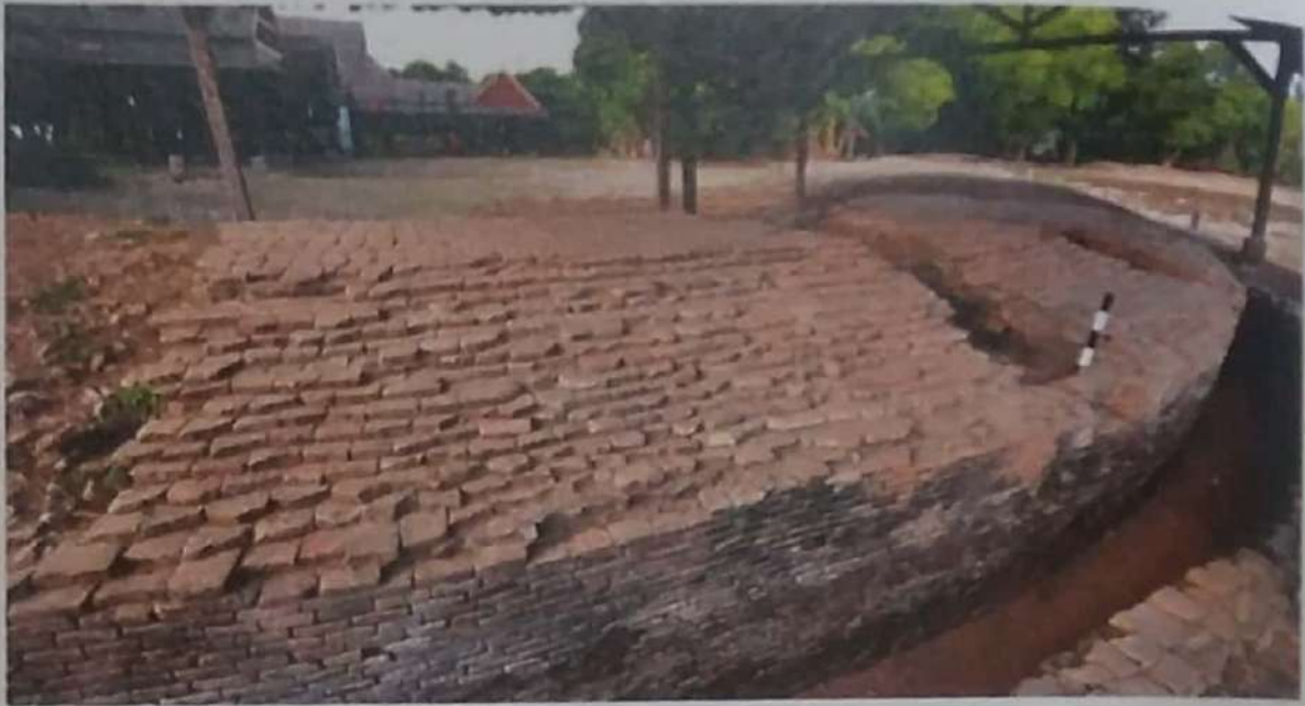
Struktur dinding Benteng Somba Opu (sumber: BPCB Prov. Sul-Sel)
