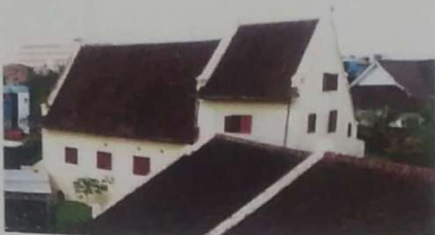
Bangunan H, tahun 2021 (sumber: BPCB Prov.Sul-Sel)
