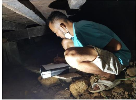
Foto 14. Pengukuran gelagar, slop dan pondasi
