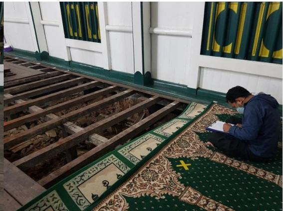
Foto 22. Pengumpulan data Kerusakan Gelagar slop dan pondasi lantai CC
