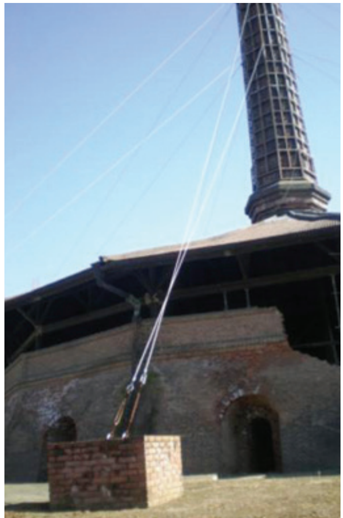
Perkuatan menara (eksterior)
