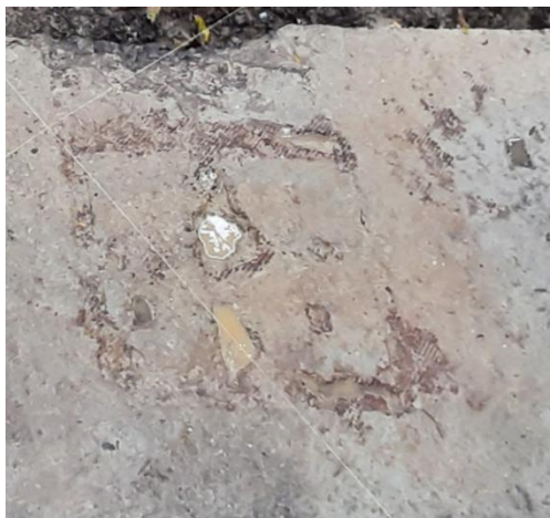
Foto 20 Kenampakan sisa-sisa kawat bendrat pada permukaan bunker
