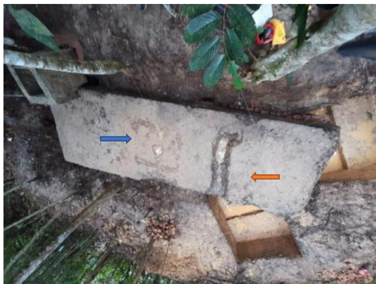
Foto 15 Jejak-jejak penambahan struktur pada permukaan bunker
