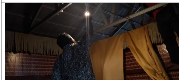
Pembongkaran instalasi listrik
