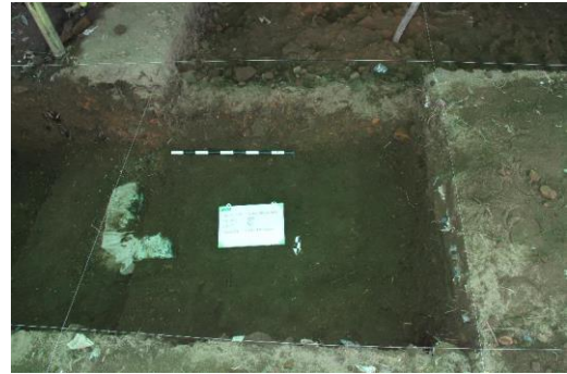
Foto 43. Kondisi Spit 5 Kotak e10, Terlihat Sebagian terpal yang Menutupi Sebagian Struktur Candi (Dok BPCB Kaltim 2020)
