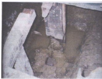
Foto Pengecoran Cakar Ayam pada 33 tiang masjid
