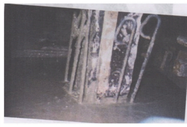
Foto Pengecoran Cakar Ayam pada 33 tiang masjid
