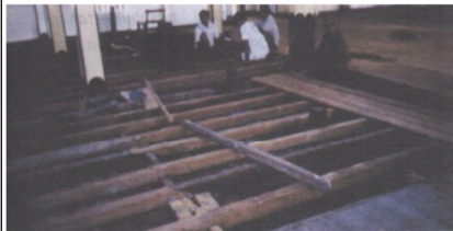
Foto Penggantian gelagar dan tulang gelagar serta lantai masjid
