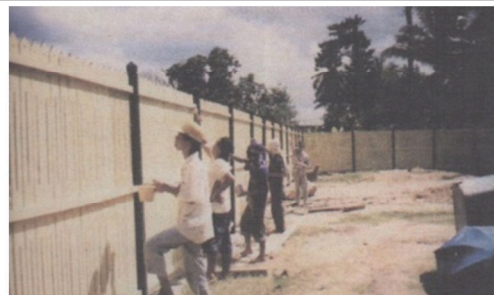
Pemasangan pagar belakang masjid
