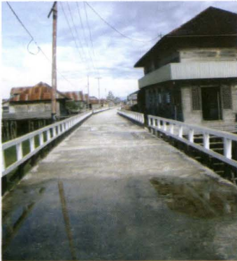
Gambar 5. Jalan rabat beton dibangun melalui PNPM-MP (Dok. pribadi, 2013)
