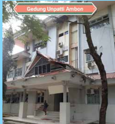
Gambar 3.6. Foto dampak gempa Ambon 2019
