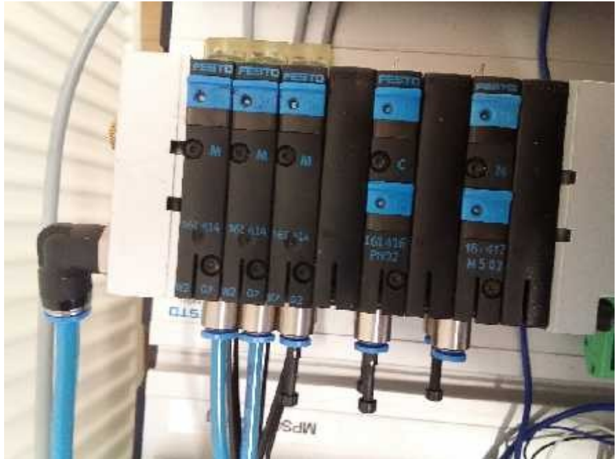
Gambar 2.26 Posisi pemasangan tubing
