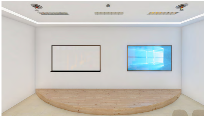
Gambar 12. Ilustrasi pemasangan smoke detector dan sprinkler .
