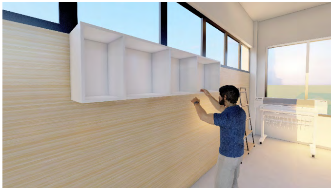
Gambar 4. Ilustrasi pengankuran lemari.
