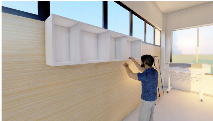
Gambar 4. Ilustrasi pengangkuran lemari
