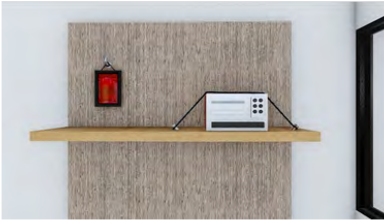
Gambar 7. Komponen non-struktur harus diberi pengaku
