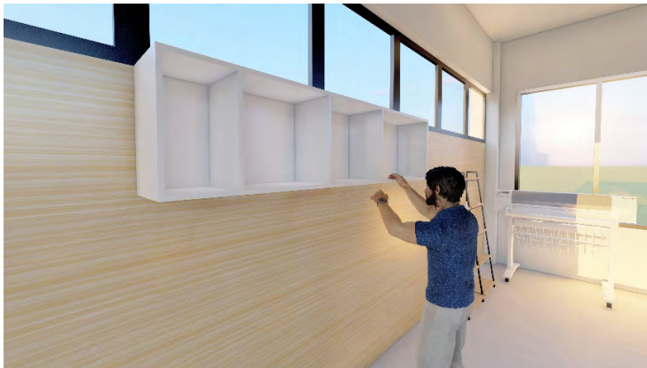
Gambar 4. Ilustrasi pengankuran lemari
