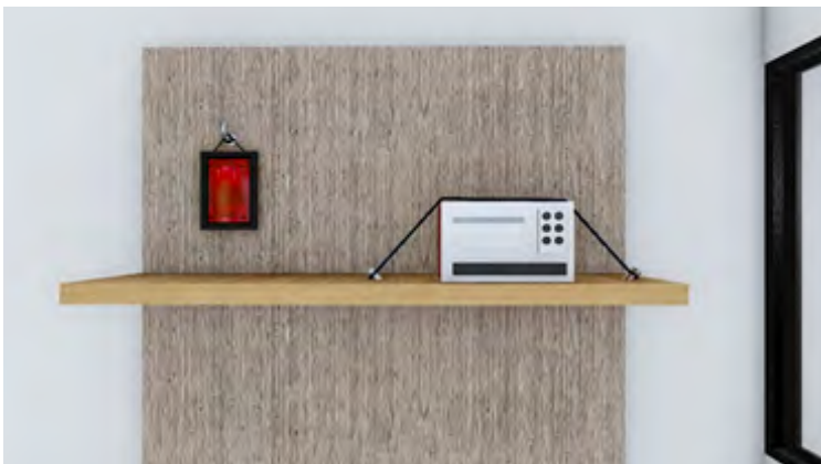
Gambar 7. Komponen non-struktur harus diberi pengaku
