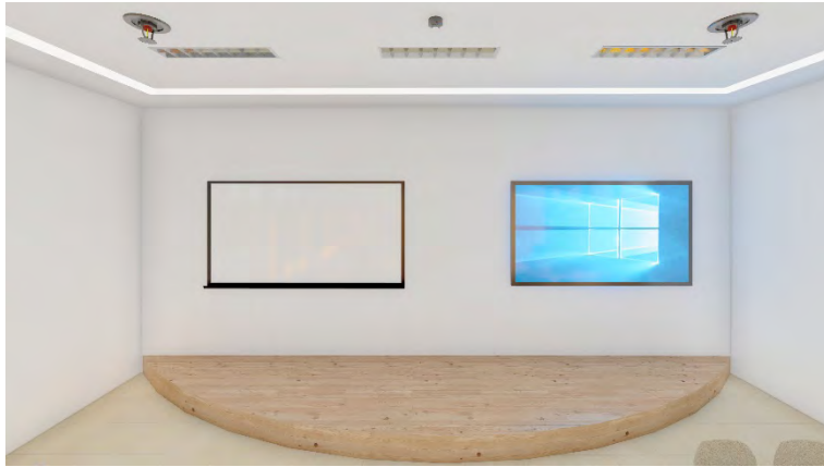
Gambar 12. Ilustrasi pemasangan smoke detector dan sprinkler
