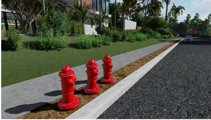
Gambar 9. Ilustrasi penempatan pipa hydrant di jalan
