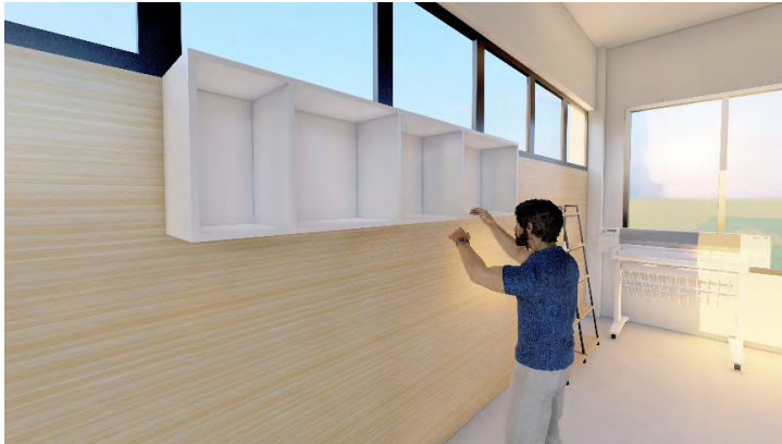
Gambar 4. Ilustrasi pengankuran lemari
