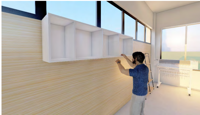
Gambar 4. Ilustrasi pengangkuran lemari
