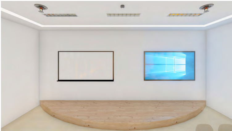
Gambar 12. Ilustrasi pemasangan smoke detector dan sprinkler
