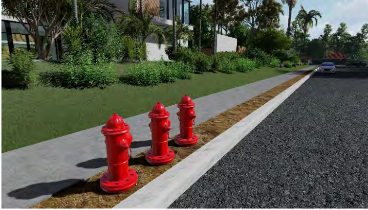
Gambar 9. Ilustrasi penempatan pipa hydrant jalan
