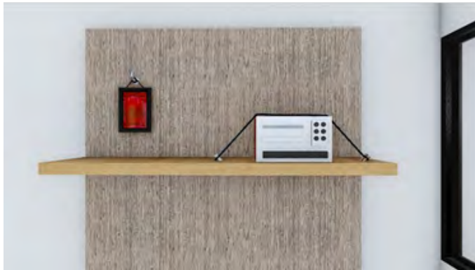
Gambar 7. Komponen non-struktur harus diberi pengaku
