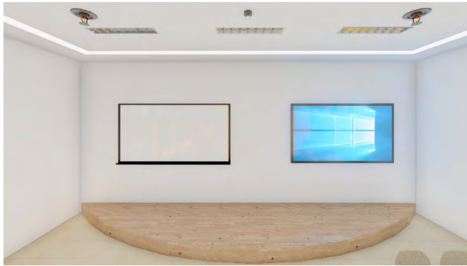
Gambar 12. Ilustrasi pemasangan smoke detector dan sprinkler
