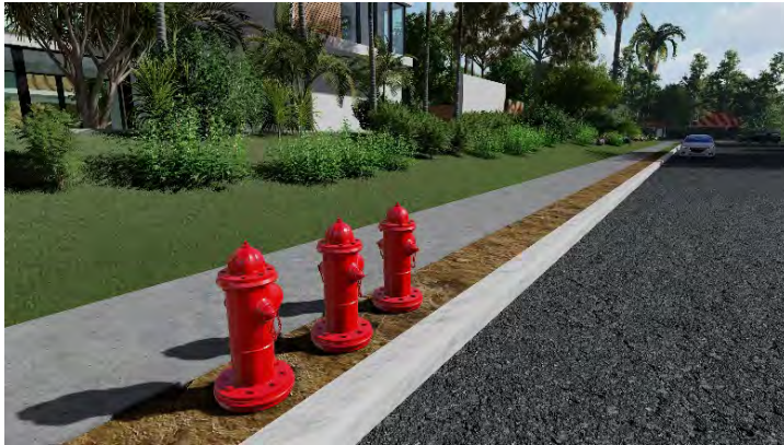
Gambar 9. Ilustrasi penempatan pipa hydrant di jalan
