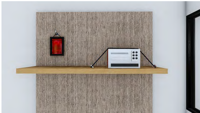
Gambar 6. Komponen non-struktur harus diberi pengaku
