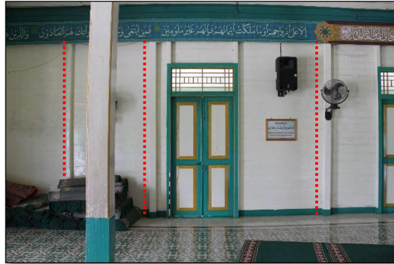
Foto 15 Rangka dinding Masjid (Dok. BPCB. Kalimantan Timur, 2018)
