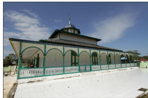
Foto 11 Tangga Masuk dari samping bangunan masjid (Dok. BPCB. Kalimantan Timur, 2018)
