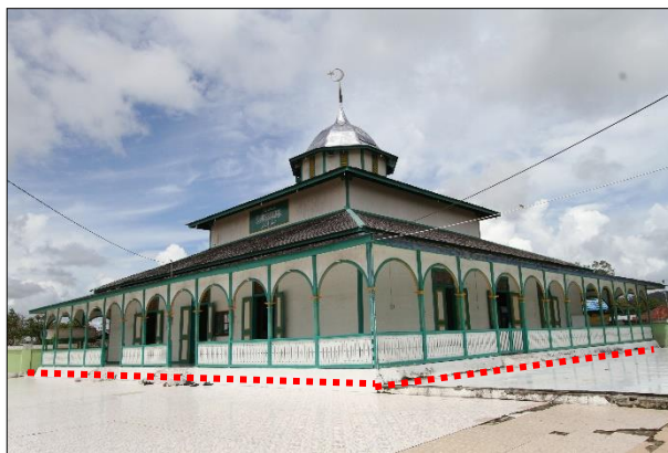
Foto 7 Bagian Fondasi Masjid Kasimuddin (Dok. BPCB. Kalimantan Timur, 2018)
