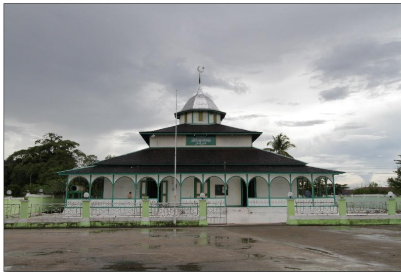
Foto.1 Tampak Depan Bangunan Masjid Kasimuddin (Dok. BPCB Kalimantan Timur, 2018)
