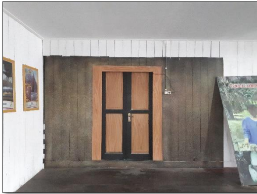
Foto 54. Pintu masuk ruangan 1 (Dok. BPCB Kalimantan Timur, 2018)
