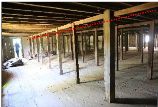
Foto 68. Slof Bagian Basement (Dok. BPCB. Kalimantan Timur, 2018)
