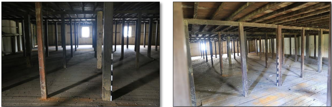
Foto 48 a&b. Kondisi Eksisting basement (Dok. BPCB Kalimantan Timur, 2018)
