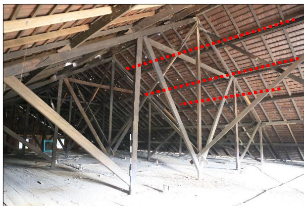
Foto 98. Gording (Dok. BPCB. Kalimantan Timur, 2018)
