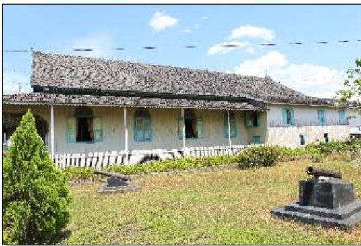
Foto 91. Jendela Ruang Pertemuan (Dok. BPCB. Kalimantan Timur, 2018)
