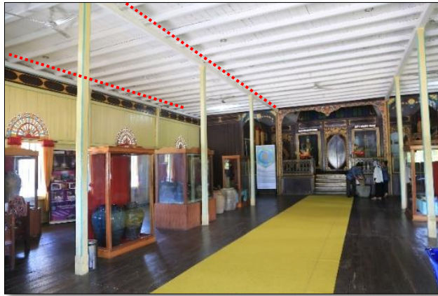
Foto 95. Balok Ringbalk pada bagian atas (Dok. BPCB. Kalimantan Timur, 2018)
