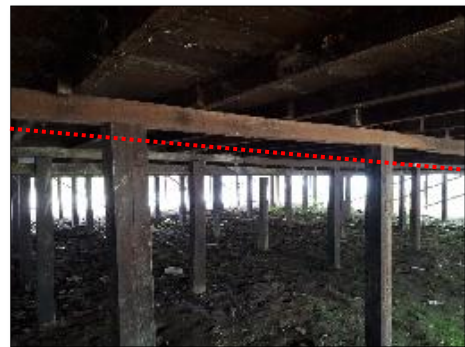
Foto 69. Slof Bagian Belakang (Dok. BPCB. Kalimantan Timur, 2018)
