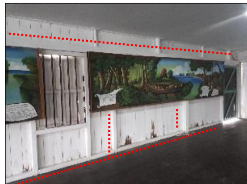
Foto 84. Rangka Dinding Ruang Transisi (Dok. BPCB. Kalimantan Timur, 2018)
