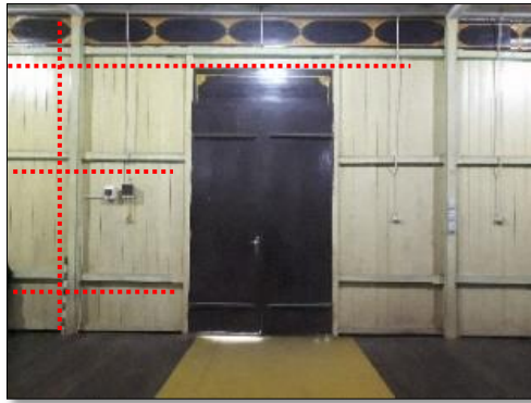
Foto 83. Rangka Dinding Ruang Pertemuan (Dok. BPCB. Kalimantan Timur, 2018)
