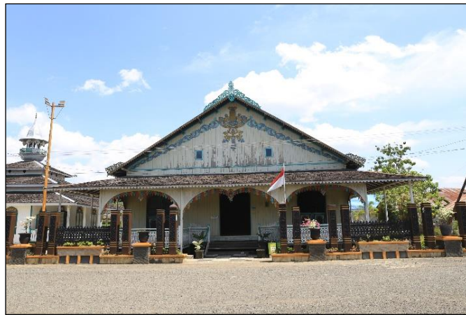
Foto 2. Tampak Depan Bangunan Istana Paser Balengkong (Dok. BPCB Kalimantan Timur, 2018)
