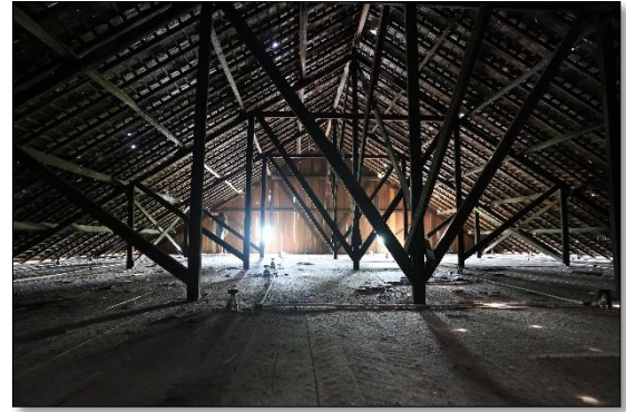
Foto 11. Kondisi eksisting loteng (Dok. BPCB Kalimantan Timur, 2018)
