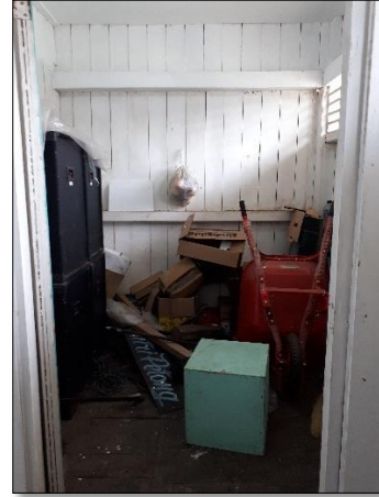
Foto 61. Kondisi eksisting ruangan 4 (Dok. BPCB Kalimantan Timur, 2018)
