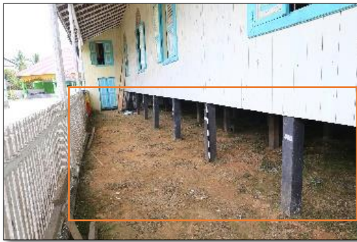
Foto 62. Fondasi Teras (Dok. BPCB. Kalimantan Timur, 2018)
