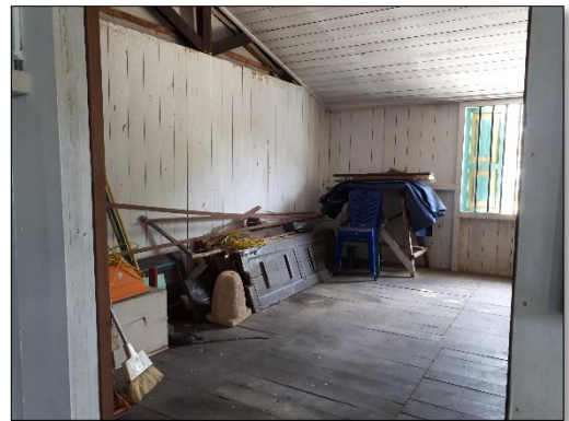
Foto 59. Kondisi eksisting ruang 3 (Dok. BPCB Kalimantan Timur, 2018)
