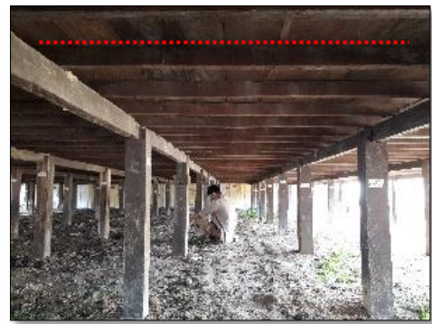
Foto 71. Gelagar Bagian Ruang Pertemuan (Dok. BPCB. Kalimantan Timur, 2018)
