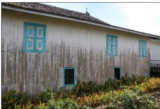
Foto 89. Dinding Basement (Dok. BPCB. Kalimantan Timur, 2018)
