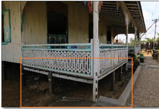
Foto 62. Fondasi Teras (Dok. BPCB. Kalimantan Timur, 2018)
