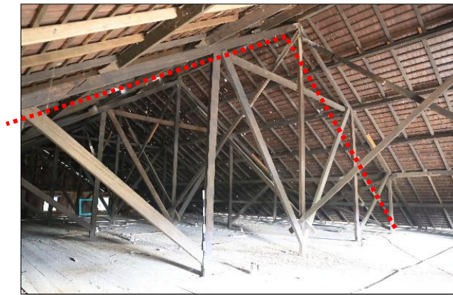
Foto 97. Kuda-kuda (Dok. BPCB. Kalimantan Timur, 2018)
