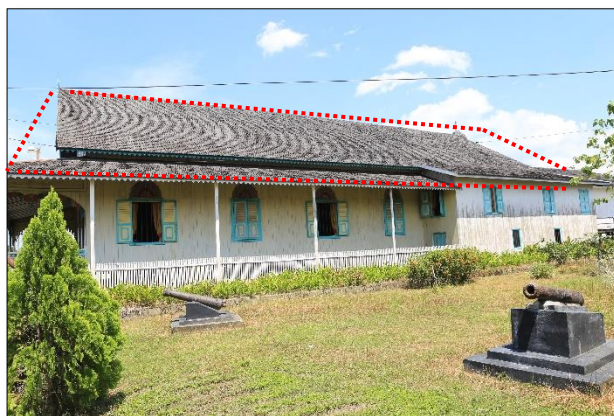
Foto 102. Penutup Atap Sirap (Dok. BPCB. Kalimantan Timur, 2018)
