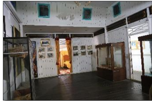
Foto 88. Dinding Ruang Transisi (Dok. BPCB. Kalimantan Timur, 2018)
