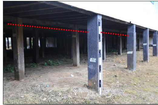
Foto 67. Slof Ruang Pertemuan (Dok. BPCB. Kalimantan Timur, 2018)
