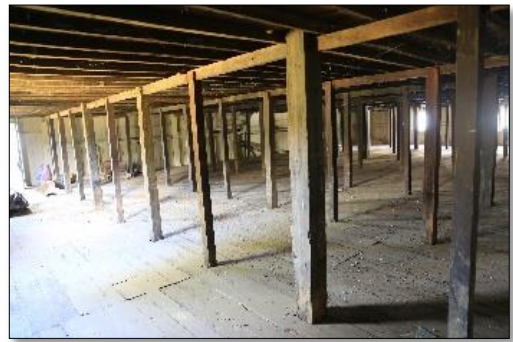
Foto 65. Fondasi Basement (Dok. BPCB. Kalimantan Timur, 2018)
