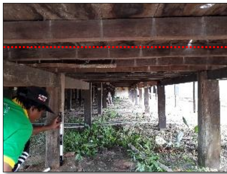
Foto 70. Gelagar Bagian Teras (Dok. BPCB. Kalimantan Timur, 2018)
