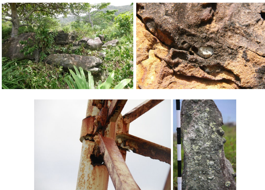
Foto 30 Beberapa identifikasi ancaman seperti tumbuhan makro di Situs Prasasti Pasir Cina, pelapukan pada batuan akibat intensitas sinar matahari di Situs Prasasti Pasir Kapal dan sarang serangga, korosi pada Menara Suar Serutu dan tumbuhan mikro pada Menhir Gunung Keramat (Dok.BPCB Kalimantan Timur, 2019)
