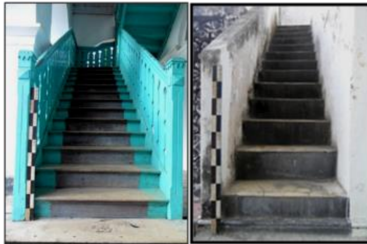
Gambar 4. Tangga depan dari kayu dan tangga belakang dari konstruksi beton masif (Sumber: Hasrianti, 2013)
