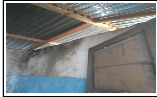
***FOTO RENCANA GUDANG PERALATAN KERJA SETELAH PEMASANGAN RANGKA DAN ATAP SENG***
