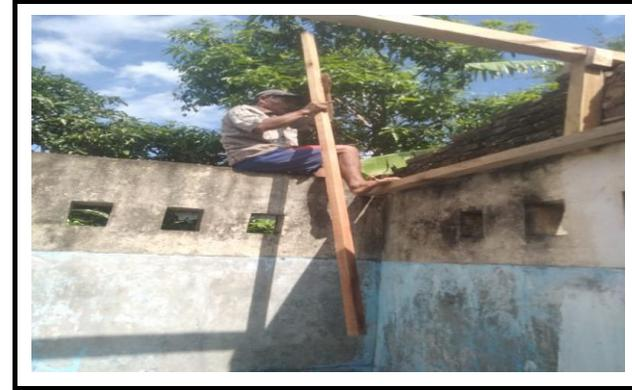
*foto; Kegiatan Pemasangan Rangka dan Atap Seng Gudang Peralatan Kerja*
