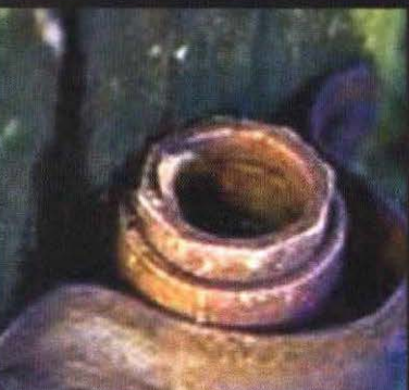
Permukaan Logam yang Kasar Cenderung Mengalami Korosi
