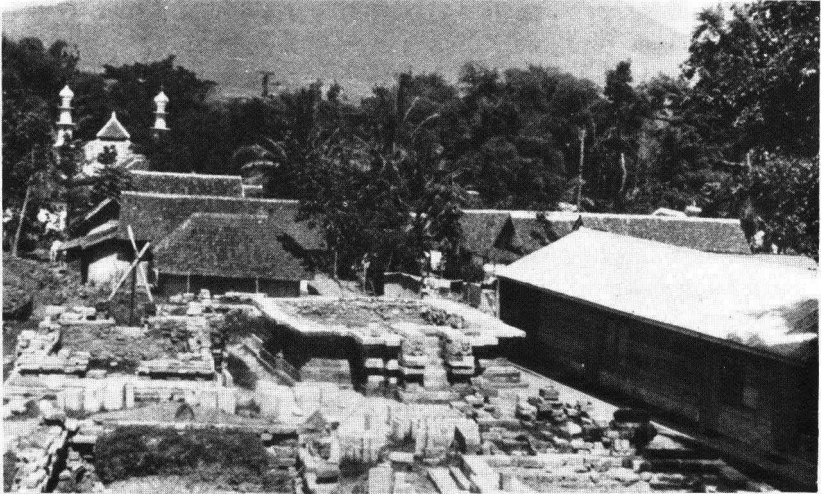
Foto No. 9 Susunan percobaan bagian tubuh Candi.
