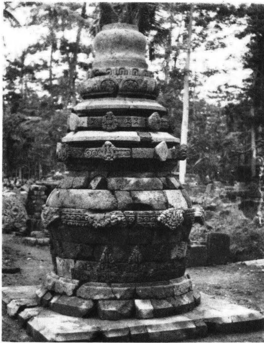
Foto No. 1. Susunan percobaan bagian puncak Candi yang berbentuk Stupa.
