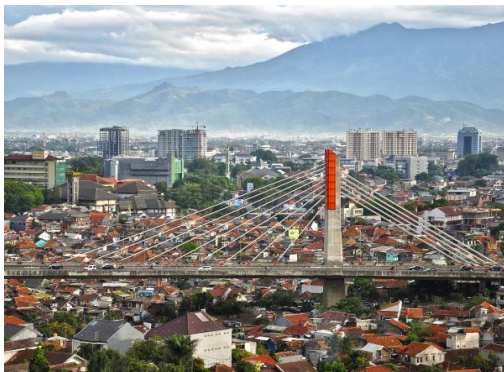
Gambar 2.1 Jembatan Pasupati yang ditahan oleh kabel baja dan satu tiang penyangga
