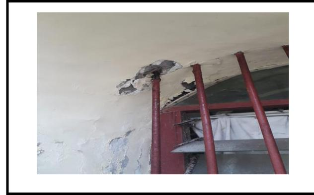
***FOTO EKSTING KERUSAKAN PLESTERAN ROLLAK BAGIAN DALAM GEDUNG K KOMPLEKS BENTENG ROTTERDAM***
