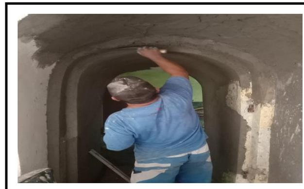
**FOTO KEGIATAN ACIAN PLAMUR SETELAH PLESTERAN DINDING DAN ROLLAK BANGUNAN GEDUNG K KOMPLEK BENTENG ROTTERDAM**
