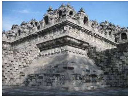
Gambar 6. Keletakan relief karmawibhangga pada kaki candi yang tertutup struktur selasar dan undag (Sumber: Balai Konservasi Borobudur, 2007)
