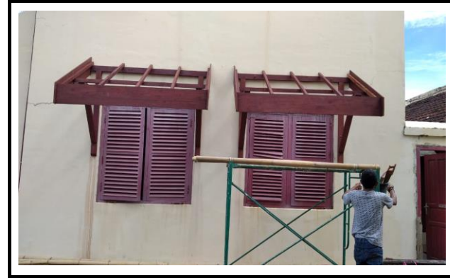
FOTO KEGIATAN PEMASANGAN RANGKA, KASO DAN LISPLANK KONSUL JENDELA
