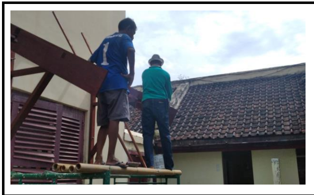
FOTO KEGIATAN PEMASANGAN LISPLANK DAN SENG PELAPIS ATAP KONSUL
