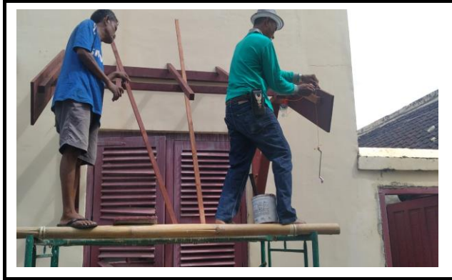
FOTO KEGIATAN PEMASANGAN RANGKA, KASO DAN LISPLANK KONSUL JENDELA
