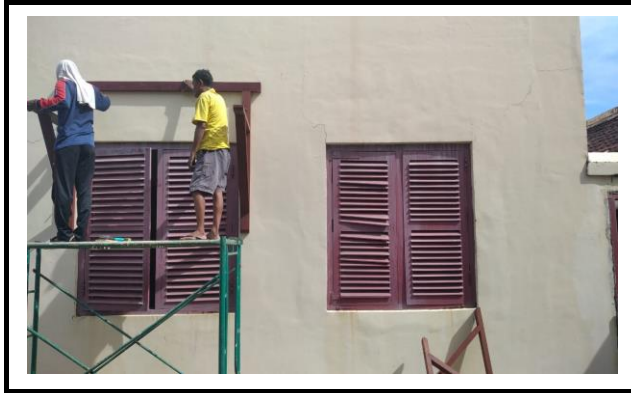
FOTO KEGIATAN PEMASANGAN RANGKA KONSUL BAGIAN BAWAH
