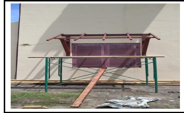
FOTO KEGIATAN PEMASANGAN RANGKA KONSUL BAGIAN BAWAH
