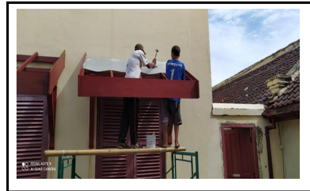
FOTO KEGIATAN PEMASANGAN LISPLANK DAN SENG PELAPIS ATAP KONSUL
