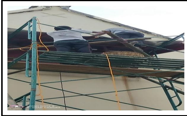
FOTO KEGIATAN PEMASANGAN RANGKA KONSUL DAN PEMASANGAN ATAP GENTENG
