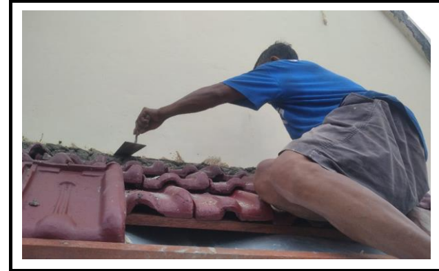
FOTO KEGIATAN PEMASANGAN RANGKA KONSUL DAN PEMASANGAN ATAP GENTENG
