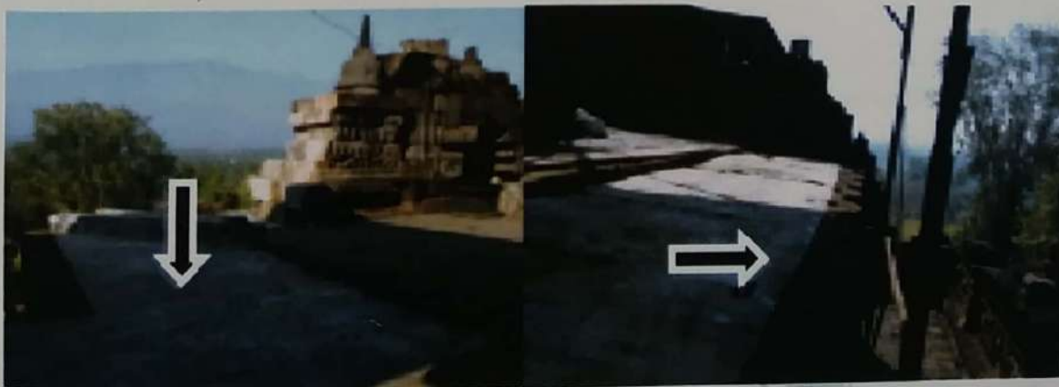
Foto 6. Lapisan timah ( lead ) yang hanya dijejer Foto 7. Lapisan timah ( lead ) yang di lubang
