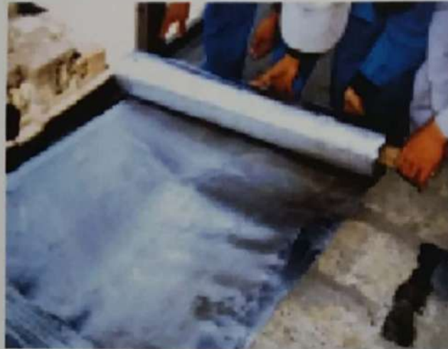
Foto 18. Pemasangan lapisan timah ( lead )
