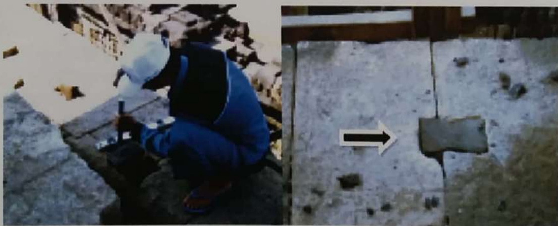
Foto 9. Pembuatan sambungan ekor burung dan sambungan ekor burung
