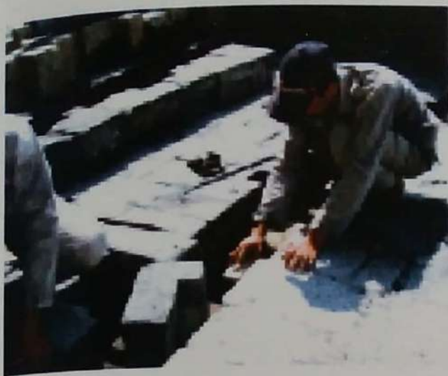
Foto 20. Pembongkaran lantai dan pembersihan saluran air
