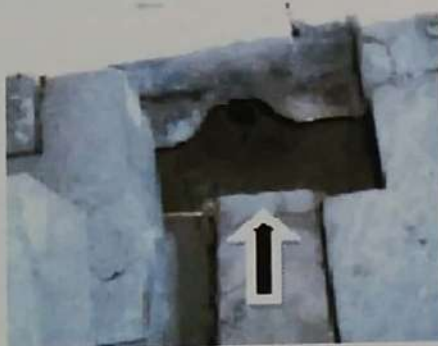
Foto 21. Pipa penampungan air dan kondisi saluran air setelah pengolesan araldite tar
