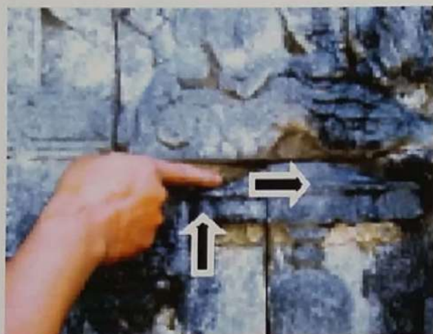
Foto 27. Titik-titik yang masih mengalami kebocoran / rembesan
