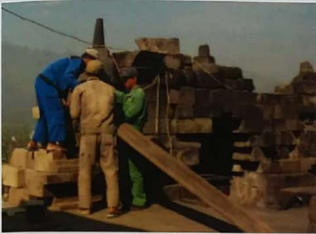
Foto 16. Proses pembongkaran batu-batu pagar langkan dan peralatan yang digunakan untuk penanda batu
