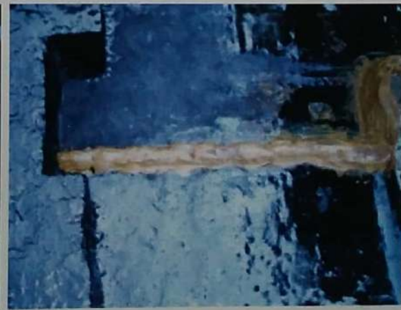
Foto 25. Pembuatan batas-batas atau kolam pengetesan kebocoran/rembesan
