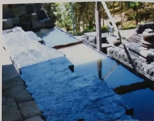
Foto 26. Pengetesan kebocoran
