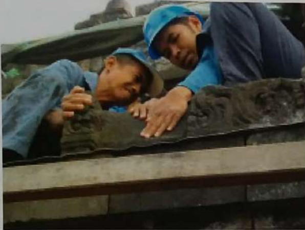
Foto 29. Pemasangan batu-batu pagar langkan
