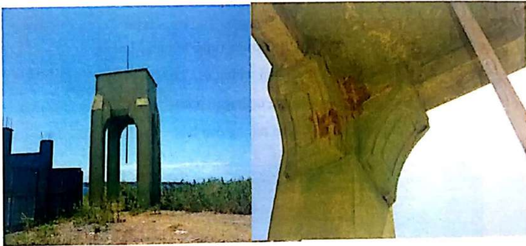
Foto 2.kiri: Bangunan tempat penampungan air dari jaman Belanda tampak arah utara. Kanan: Lengkungan-lengkungan penyangga tambahan dengan hiasan pola bingkai garis timbul
