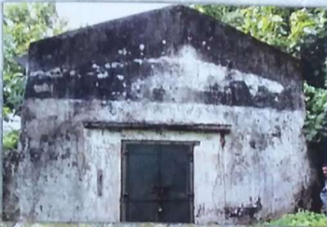
Kondisi Gudang Senjata Detasemen Peralatan TNI AD dari arah timur (dok. BPCB MAKASSAR 2010)
