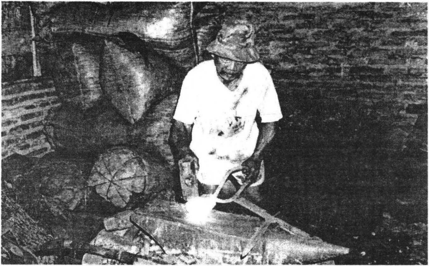
Besi yang panas diletakkan diatas paron untuk dilakukan penempaan.
