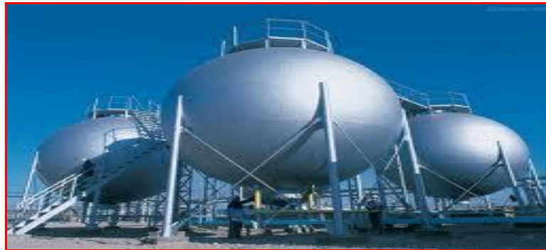
Gambar 23. Tangki penyimpanan bahan baku gas yang berbentuk bola.
