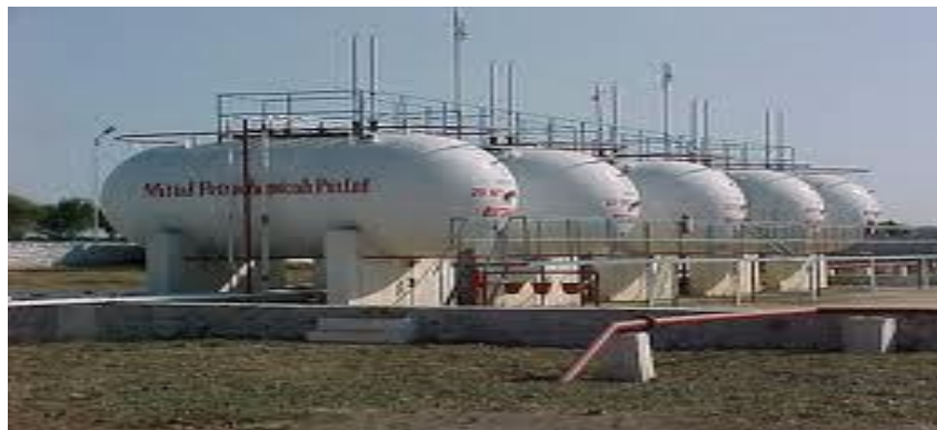
Gambar 24. Tangki penyimpanan bahan baku gas yang berbentuk ellips bulat telur. ( www.bharattanksandvessel.com ).
