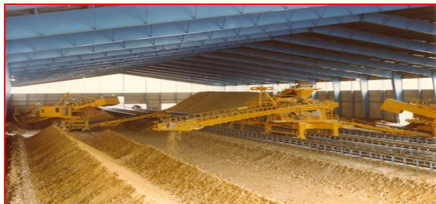
Gambar 11. Penyimpanan indoor sistem timbunan dengan konveyor pembawa( www.bulk.com ).
