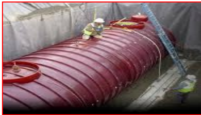
Gambar 19. Pemasangan tangki penyimpanan bensin dibawah tanah. ( www.bharattanksandvessel.com ).
