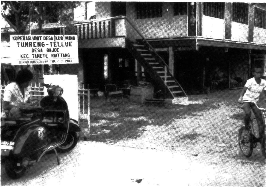
Gambar 5 Bangunan KUD Mina.
