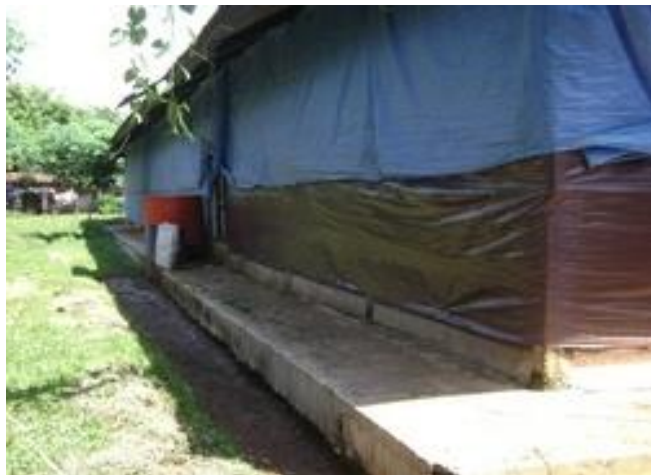
Gambar 29. Tirai kandang yang sudah terpasang
